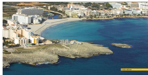
Vista aérea de la desembocadura del torrente.
